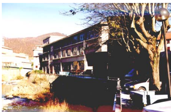
Il fabbricato produttivo ex "Cerusa"
