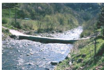
Il manufatto in alveo (guado) a monte degli insediamenti produttivi in loc. Groppo
