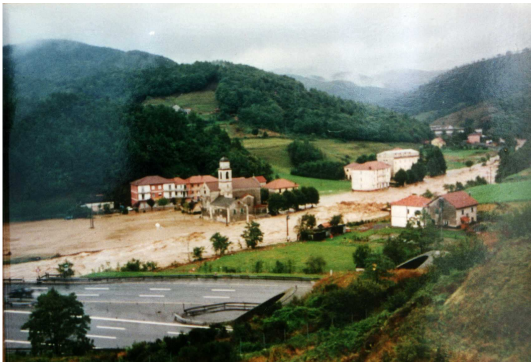
Figure 4.1, 4.2 e 4.3 – Esondazione prodotta a seguito degli eventi meteorici del 1993 in località S. Pietro di Masone
